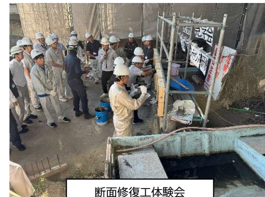
断面修復工体験会 (R7.9.26 魚見二号橋)
