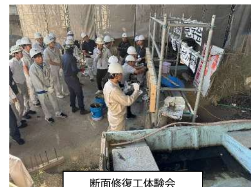
断面修復工体験会 (R7.9.26 魚見二号橋)
