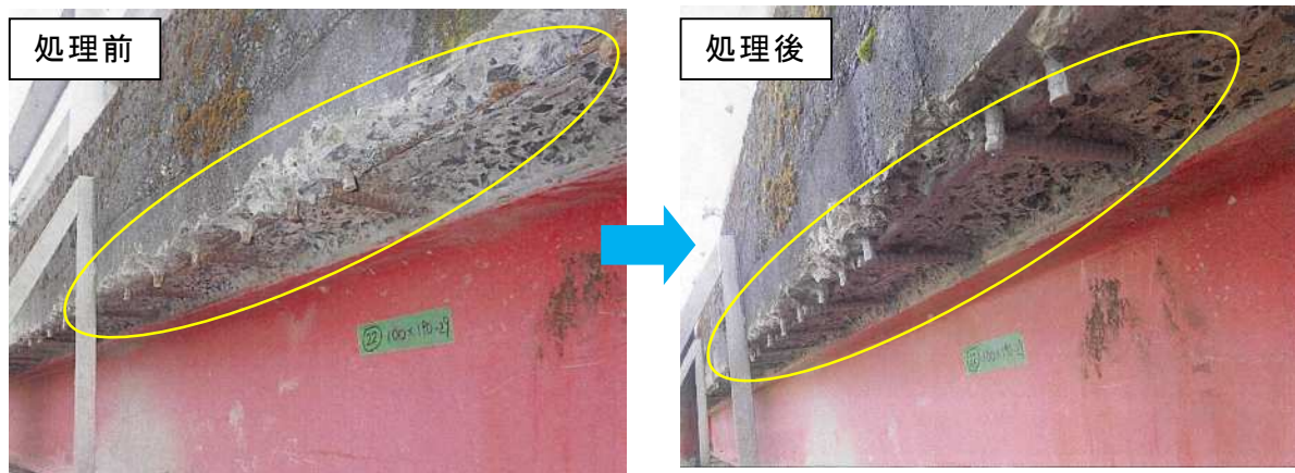
露出鉄筋の防錆処理事例
