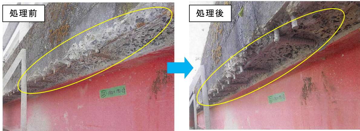
露出鉄筋の防錆処理事例
