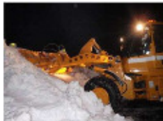
ショベルローダ (北陸地方整備局) による圧雪起し (坂井市)
