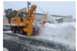
ロータリー除雪車 (関東地方整備局) による除雪・拡幅状況 (あわら市)
