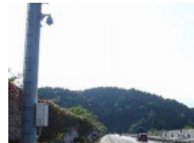
監視カメラの増設
