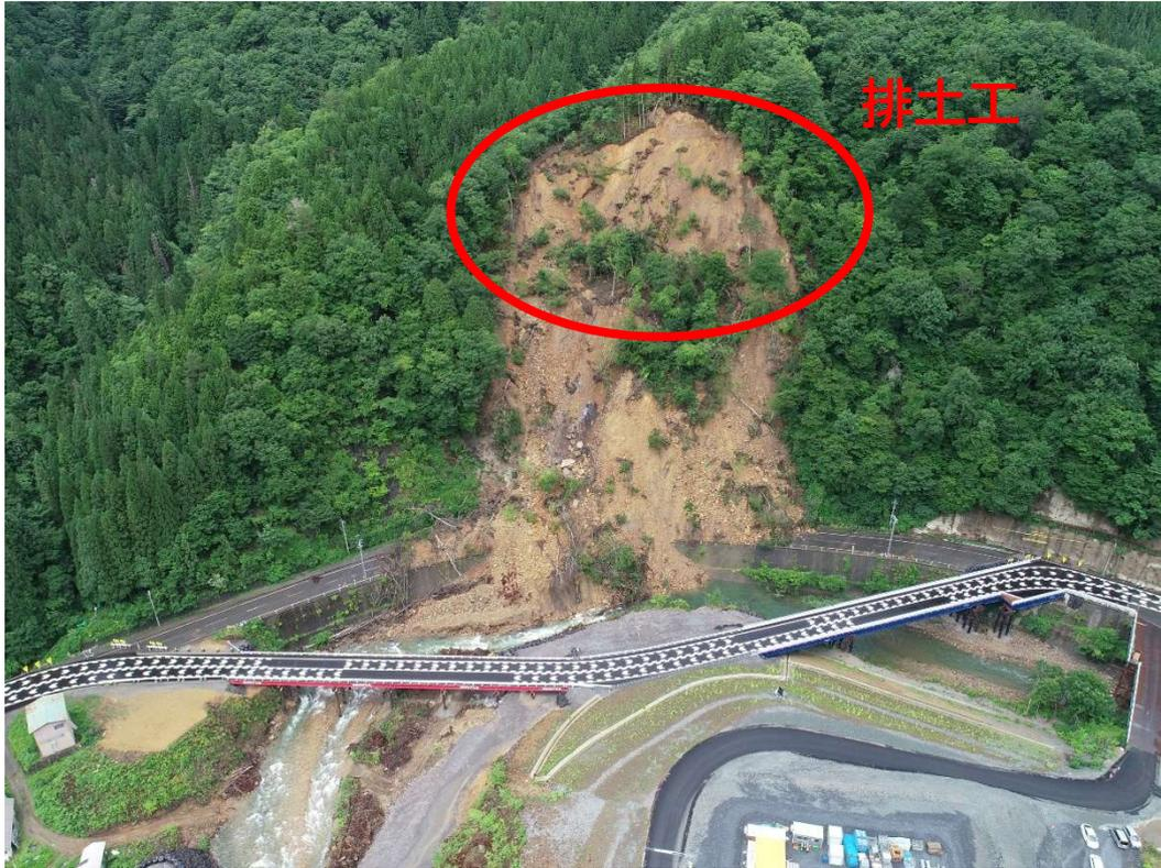
写真 1. 応急的な措置（排土工）
