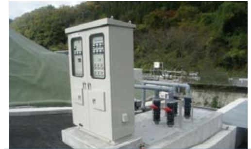
浸出水導水ピット
