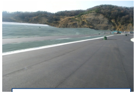
■キャッピング工(舗装) アスファルト舗装工: 65,900m 2
