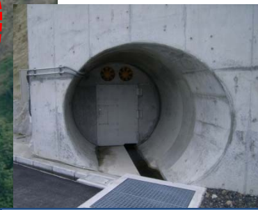
■ドレーントンネル工 延長: 1,095m
