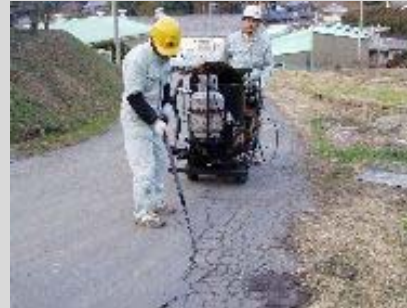
アスファルト舗装のシール材によるクラック補修(例) (社)日本道路建設業協会HPより
