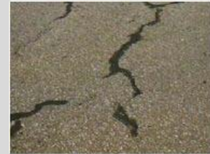
アスファルト舗装のシール材によるクラック補修(例) (社)日本道路建設業協会HPより
