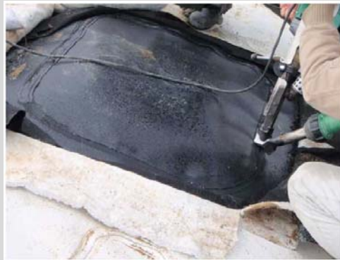
溶着による遮水シートの補修状況
