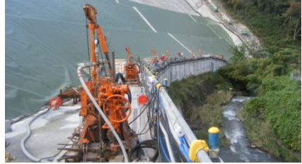
■鉛直遮水工 【連続地中壁工】 施工延長: 北側L=315m, 南側L=486m
