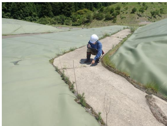
遮水シート固定工の点検
