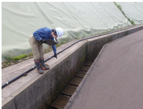
雨水集排水設備の点検
