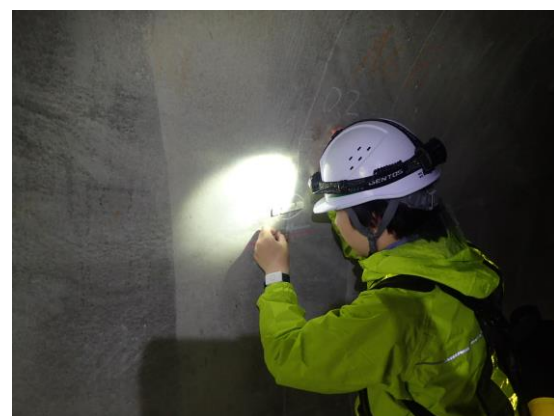
ドレーントンネルの点検
