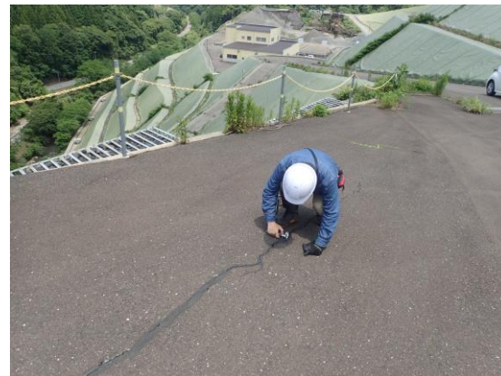
キャッピングアスファルトの点検
