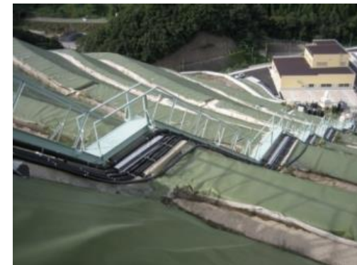
保有水導水管
