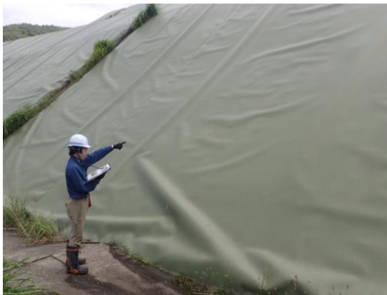
遮水シートの点検
