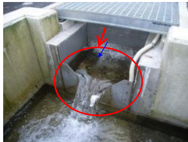
排水量測定のための三角堰
