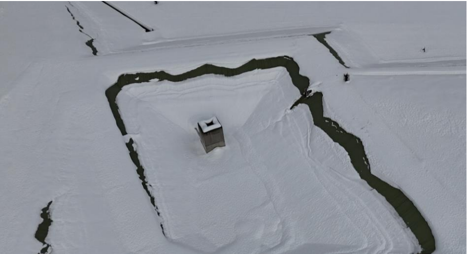
防災調整池の状況撮影(大雪後の徒歩で到達困難時に撮影)
