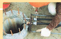
地盤へ地中熱を吸収するパイプを通す作業
