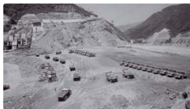
建設中の長野ダム(現九頭竜ダム) (写真提供: J-POWER電源開発株式会社)
