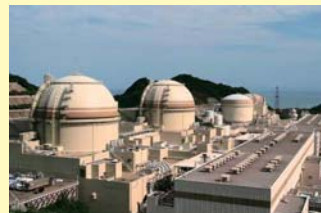
関西電力大飯発電所 (写真提供: 関西電力株式会社)
