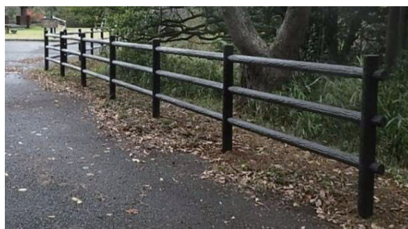
老朽化した遊歩道の転落防止柵の更新
