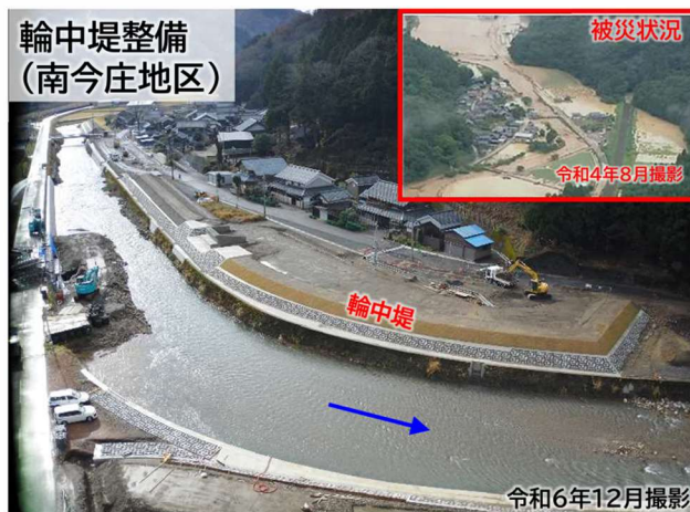
現在整備中の輪中堤（南越前町 南今庄地区）
