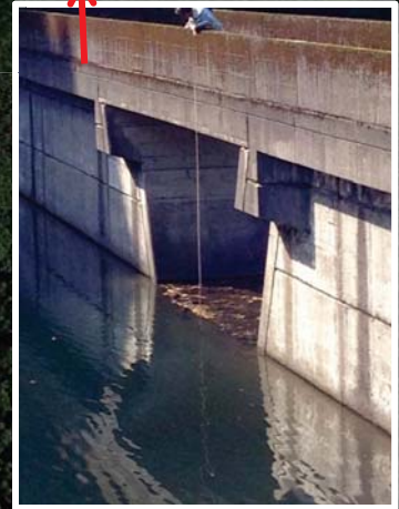
水位・流量・流速測量予定地
