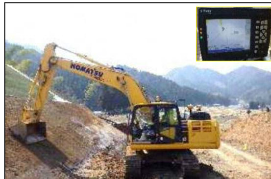
ICT建設機械による施工
