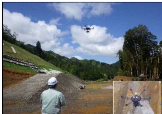
ドローンによる写真測量
