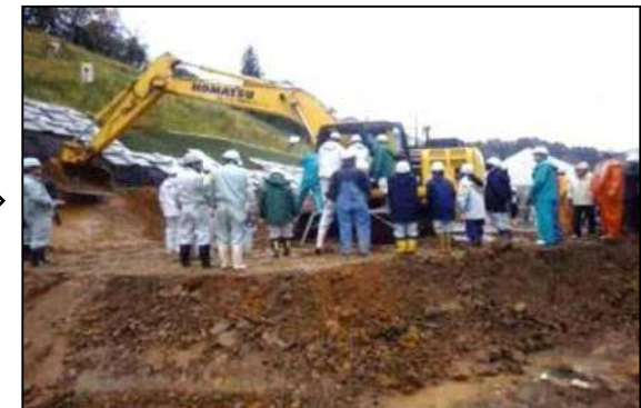
地元建設業者への見学会
