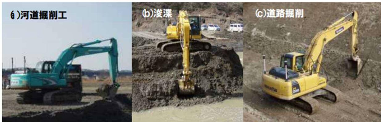
写真-2 「ICTバックホウの適用範囲 (例)」
