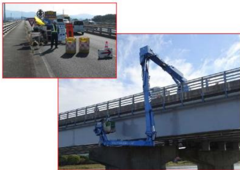
従来点検(H26～H30: 1巡目点検)
