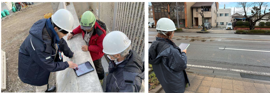
タブレットを活用し、現場にて図面の確認や消雪設備の操作を実施
