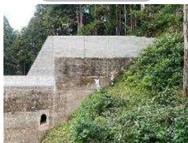
砂防施設点検
