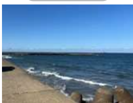
港湾施設点検
