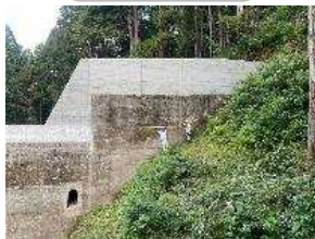
砂防施設点検
