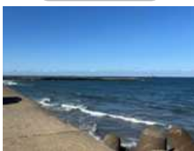
港湾施設点検
