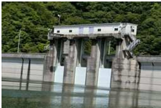
写真1 洪水吐ゲート(機械設備)
