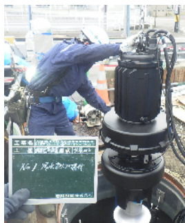
ポンプ据付工事 （九頭竜川流域下水道）
