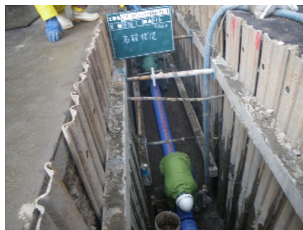
開削による管布設工事（福井市）
