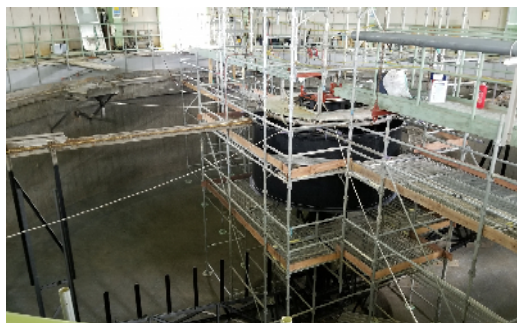
五領川浄化センター 最初沈殿池 汚泥掻き寄せ機 長寿命化工事 （五領川公共下水道事務組合）
