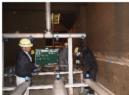
九頭竜川浄化センター 反応槽 散気装置設置（九頭竜川流域下水道）
