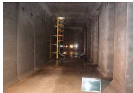
雨水調整池の整備工事（高浜町）
