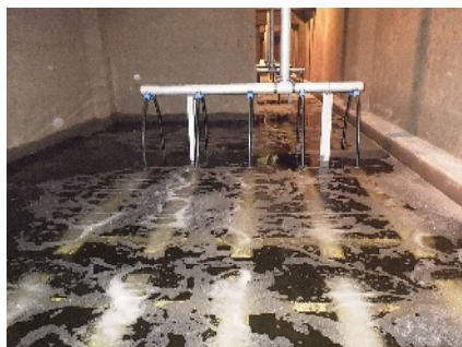
九頭竜川浄化センター 反応槽 散気装置設置（九頭竜川流域下水道）
