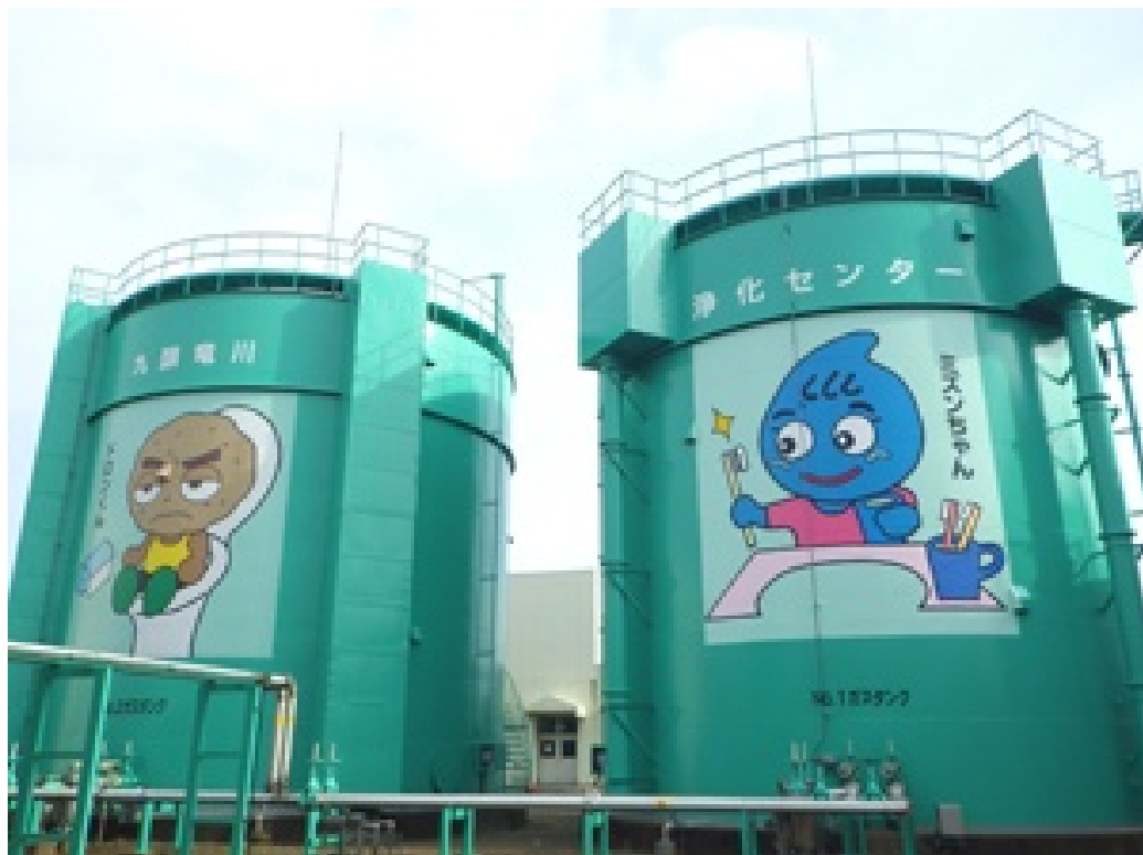
九頭竜川浄化センターのガスタンク
