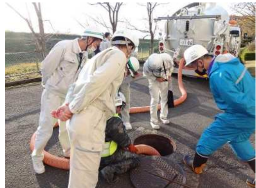
バキューム車による汚水運搬
