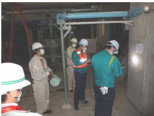
処理場の緊急点検
