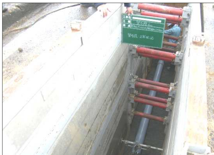
管布設工事【敦賀市】
