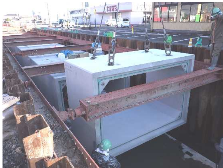
雨水管きよ（開削）整備工事【敦賀市】
