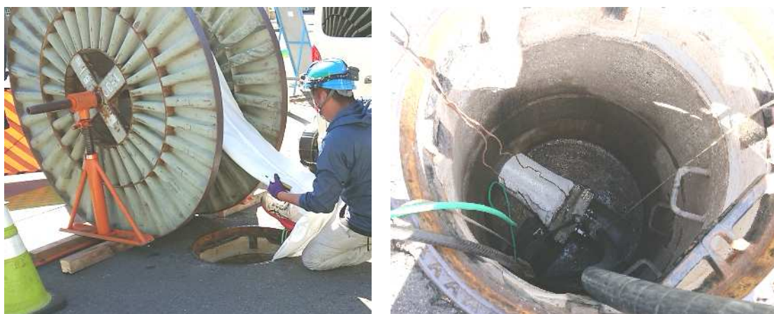
管更生（掘削せずに下水道を新しくする）工事【福井市】
