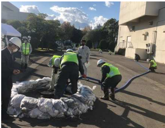
2) 仮設ポンプデモ演習
