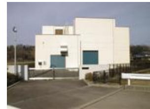
北湊ポンプ場
