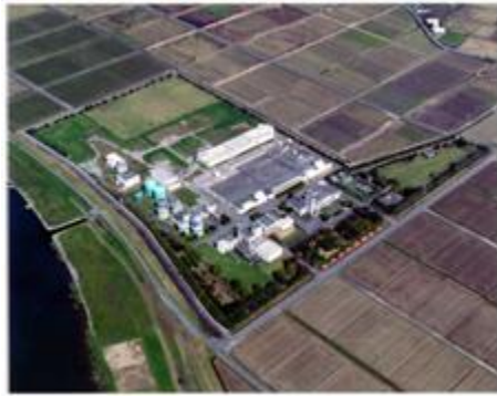
九頭竜川浄化センター
