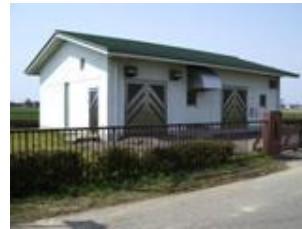
春江ポンプ場
