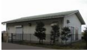
片川ポンプ場
