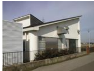
芦原ポンプ場
