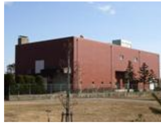
竹田川ポンプ場
