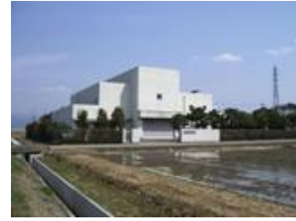
兵庫川ポンプ場
