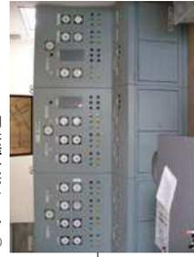
⑤ 排水ポンプ・補機監視盤 (右2面) 受電・発電監視盤 (左1面)
