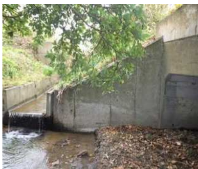
写真-1 翼壁・水叩き
