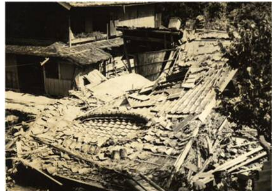
倒壊した家屋（若狭町(旧上中町)河内）
