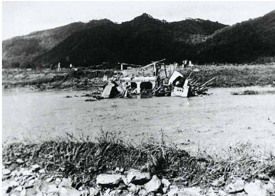
橋の流失状況（小浜市）
