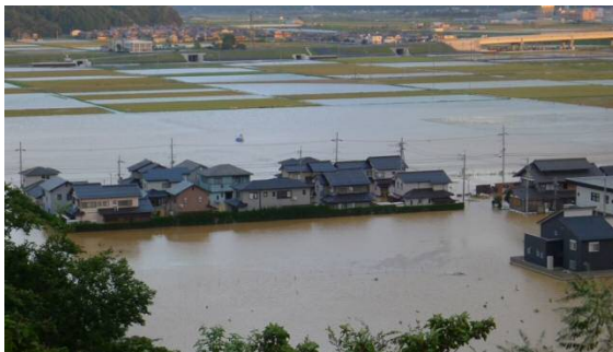
浸水被害状況（小浜市羽賀）
