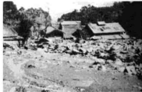
土石流発生状況（若狭町(旧上中町)河内）
