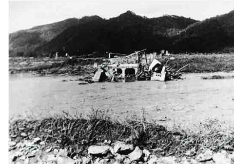
橋の流失状況（小浜市）
