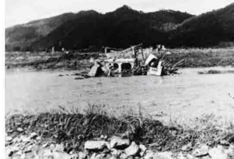
橋の流失状況（小浜市）
