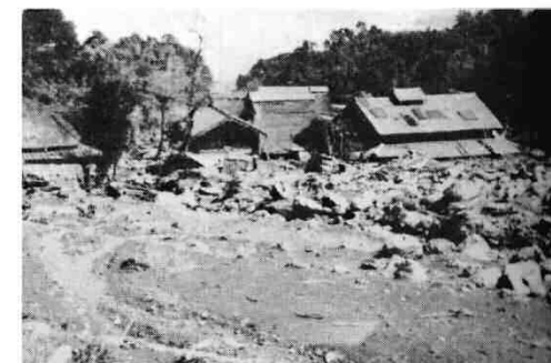
土石流発生状況（若狭町(旧上中町)河内）
