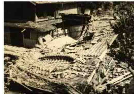
倒壊した家屋（若狭町(旧上中町)河内）
