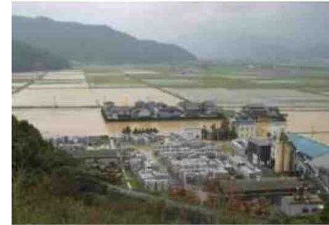
浸水被害状況（小浜市羽賀）
