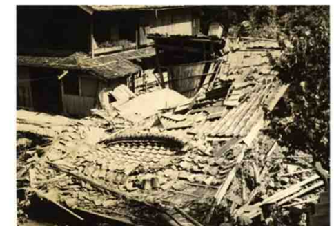
倒壊した家屋（若狭町(旧上中町)河内）
