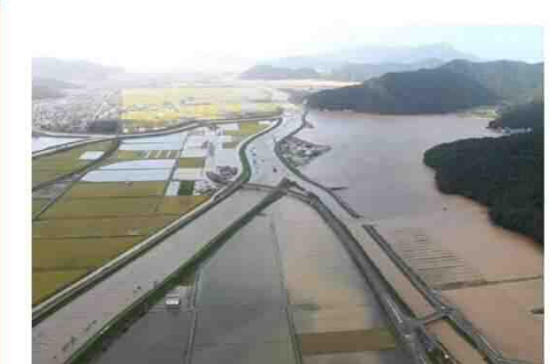
浸水被害状況 （小浜市太良庄、若狭町（旧上中町）下野木）
