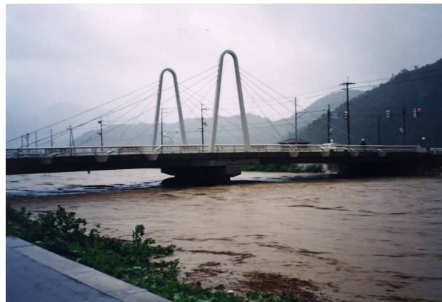
出水状況 (平成10年9月22日、大飯橋)
