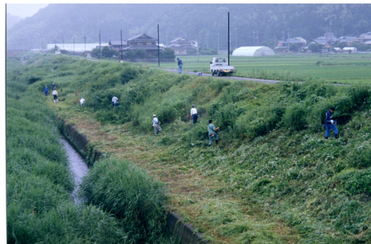
堤防の除草作業のようす (万願寺橋下流)
