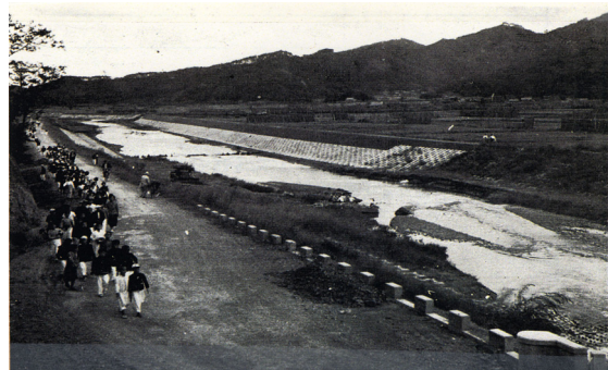
改修後の河川風景 (昭和 34 年、明神橋下流)
