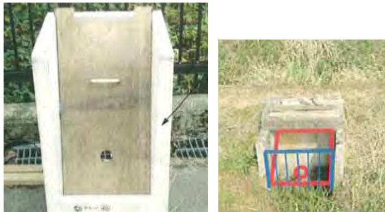
オリフィス付き調整板と切り欠き部への調整板設置のイメージ (出典：水田貯留試行調査地元意見交換会資料 富山市河川港湾課)
