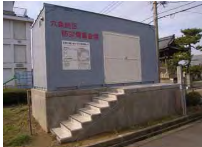
六条地区倉庫
