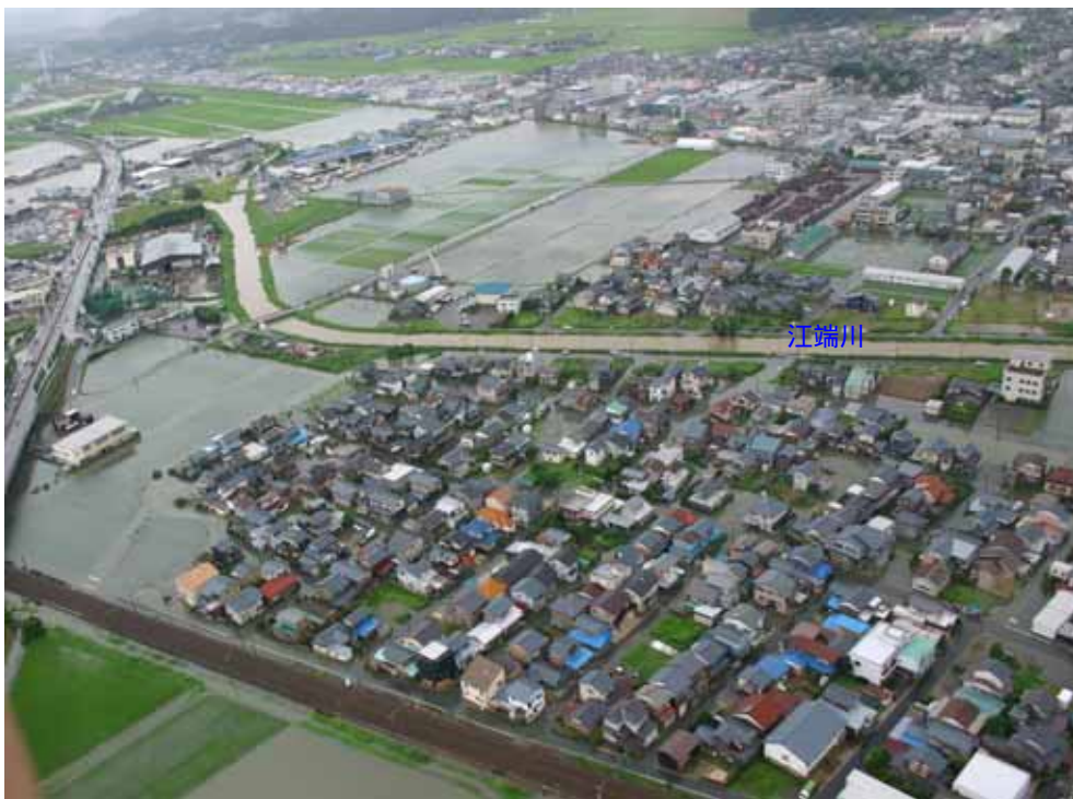
平成 18 年 7 月梅雨前線豪雨による江端町周辺の浸水状況
