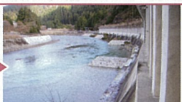
突堤設置後 上流側4基
