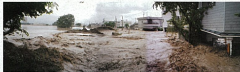
足羽川破堤箇所
