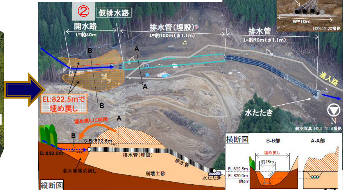
H23.12 河道閉塞対策工事完成
