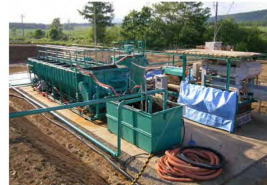
③ 濁水処理施設の事例
