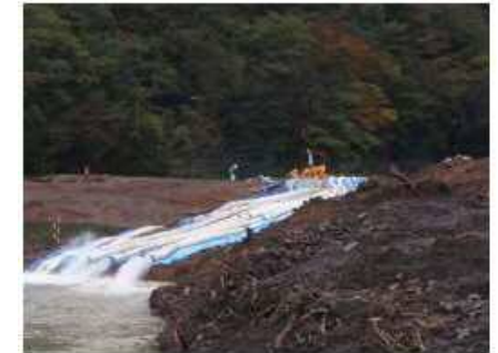
① ポンプ排水状況
