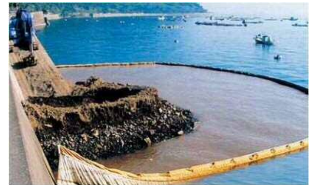
② 濁水防止フェンスの事例
