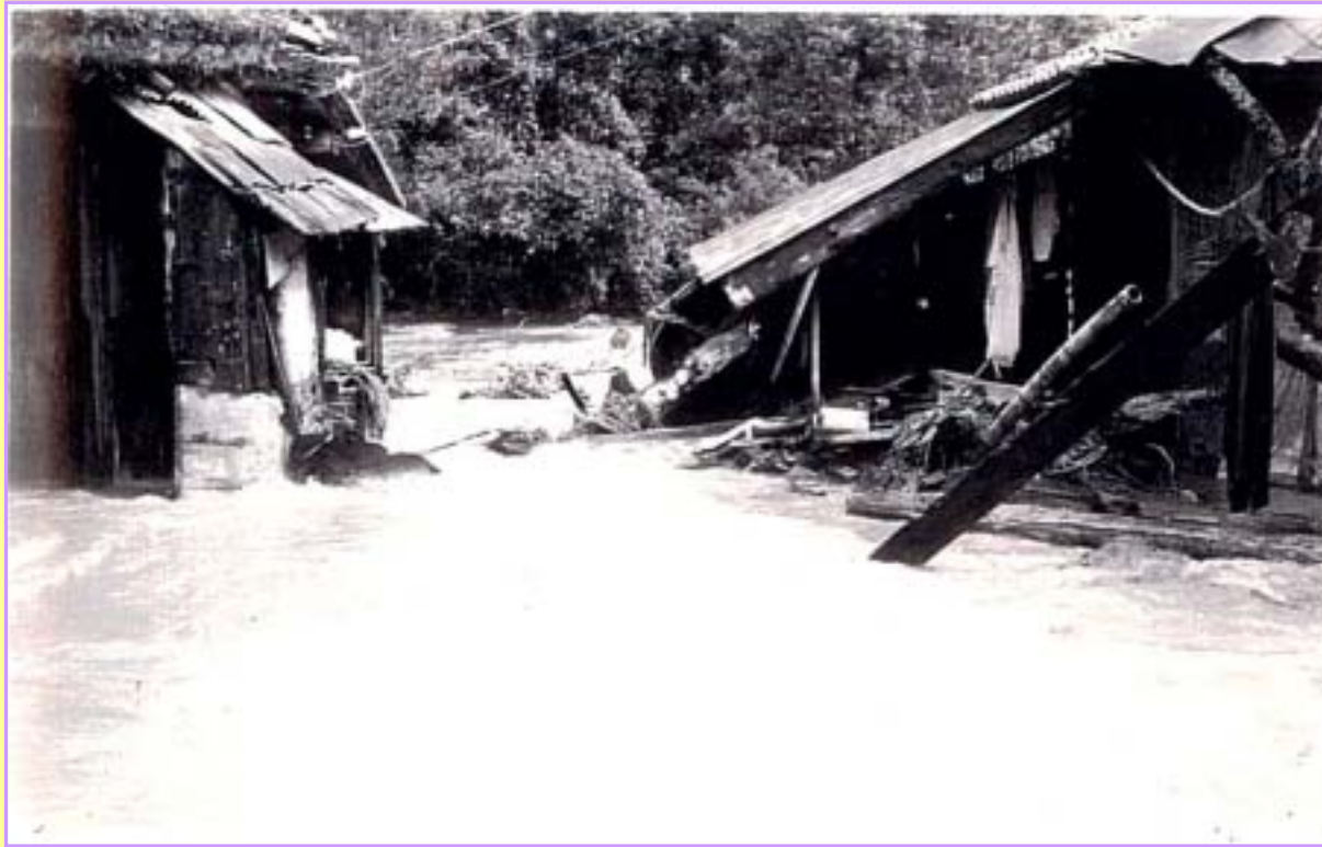
笙の川 支川 助高川の被害(昭和40年9月18日)
