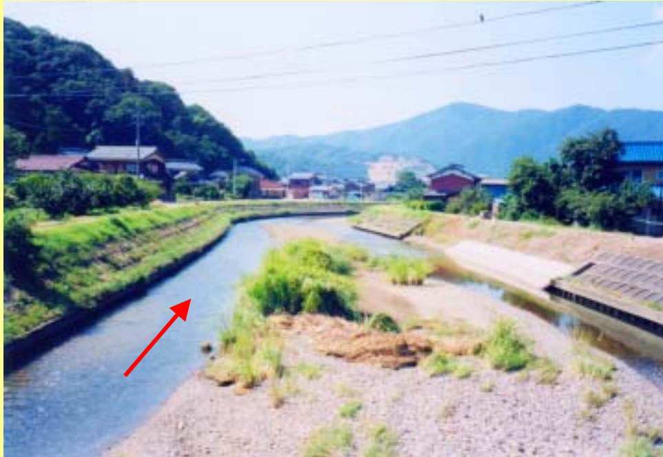
樋詰橋より下流を望む
