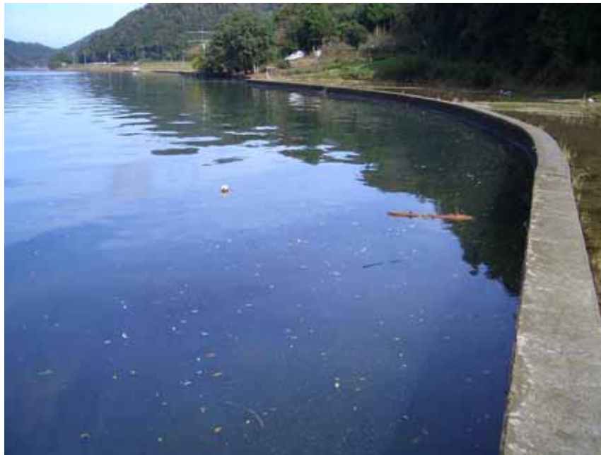
写真 現況湖岸堤(菅湖・気山地区)
