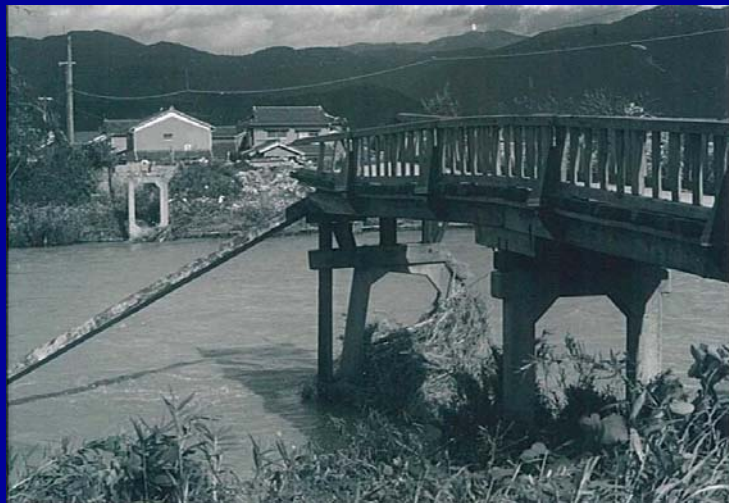
▲ 笙の川河口付近 来迎寺橋の流失 左岸:松島町側より
