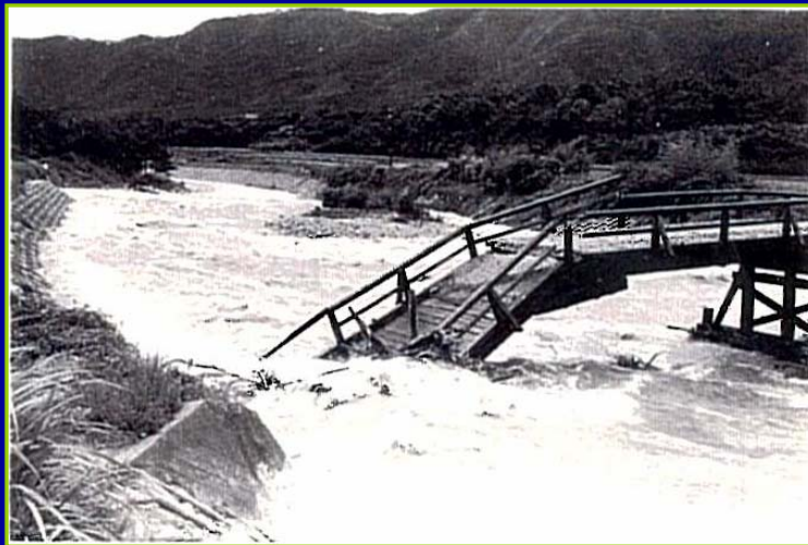
▲ 笙の川に架かる木橋流出 床上・床下浸水、堤防決壊・破損等の被害
