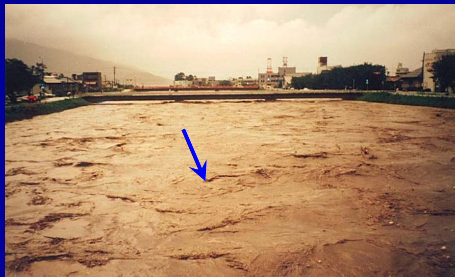
▲ 笙の川呉竹地点において、観測史上最高水位を記録し、非常に危険な状態となった
