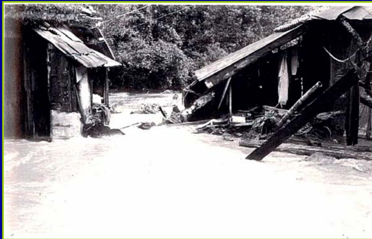
▲ 助高川の被害状況 床上・床下浸水、田畑冠水流出、堤防決壊 等の被害
