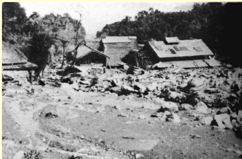
土砂流が民家へ(河内川流域)
