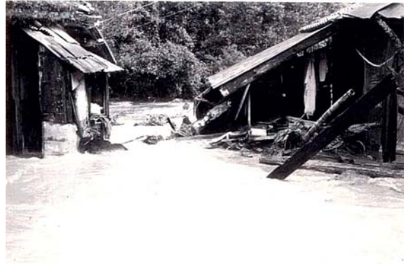
助高川の被害
