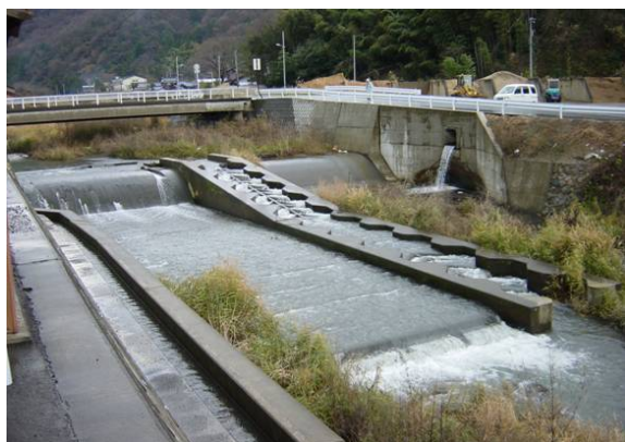
大蔵堰の魚道 (木の芽川，合流点より約 3.6km)
