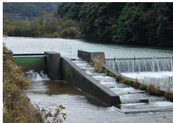
道の口頭首工の魚道 (笙の川，河口より約 5.0km)
