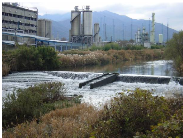
笙の川河口より約 2.2km の三島堰
