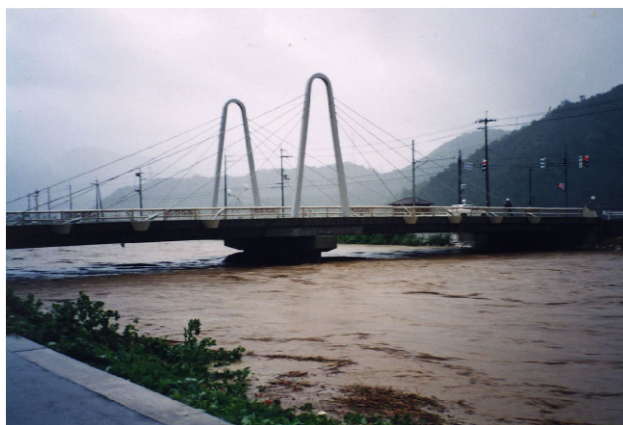
出水状況 (平成10年9月22日、大飯橋)
