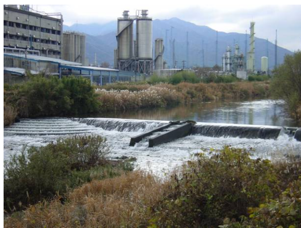
笙の川河口より約 2.2km の三島堰
