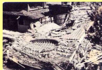
倒壊した家屋(河内川流域)
