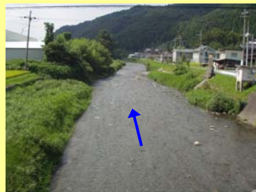
北川上流部(若狭町熊川)
