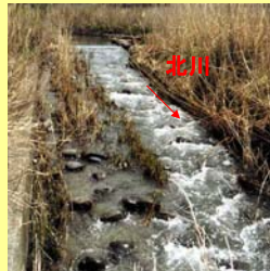
堤床固工の魚道
