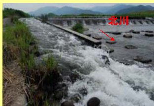
府中頭首工の魚道
