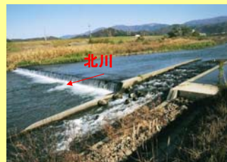
成之部床固工の魚道
