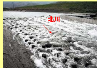
孫城床固工の魚道
