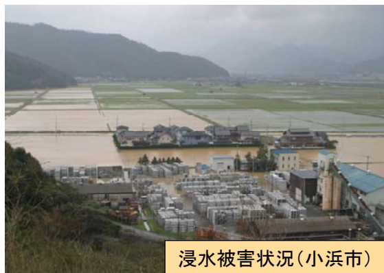
浸水被害状況(小浜市)
