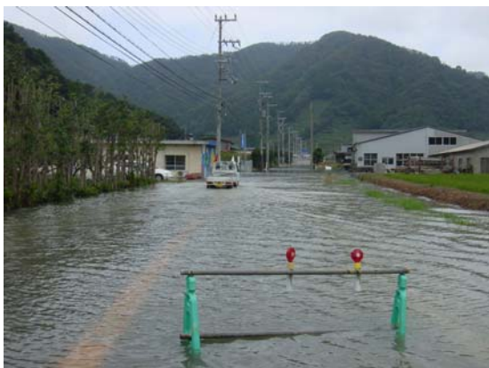
田井地区浸水状況(平成 16 年 10 月洪水)
