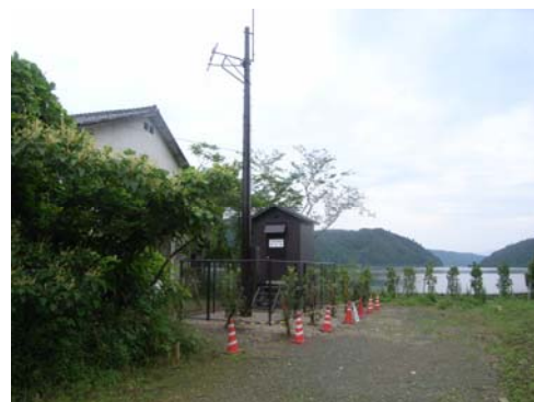
写真 三方湖水位観測所 (田井地先、平成 21 年度設置)
