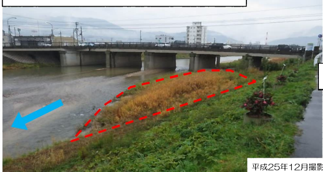
堆積土砂の除去（笹の川 敦賀市呉竹町）
