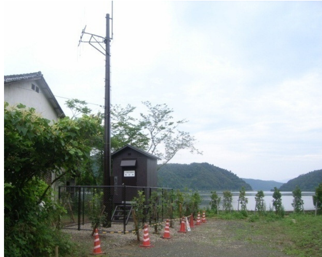
三方湖水位観測所(田井地先) 平成21年度設置
