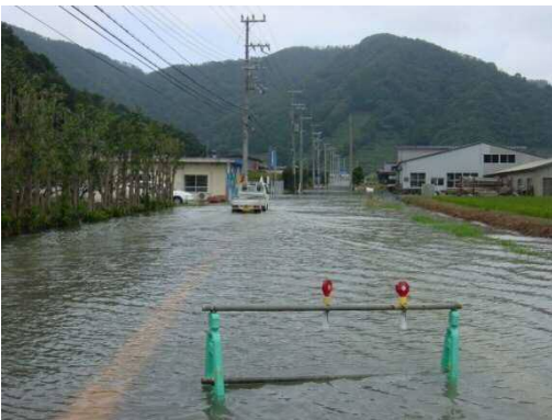
田井地区浸水状況（平成 16 年 10 月洪水）
