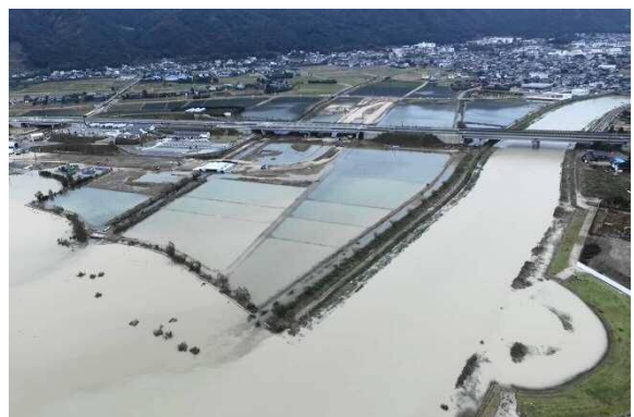
生倉地区浸水状況（平成 29 年 10 月洪水）
