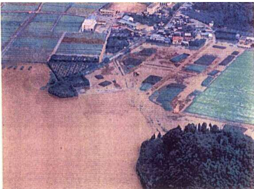
田井地区浸水状況（平成 11 年 8 月洪水）
