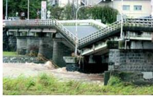
橋脚の洗掘による被災状況
