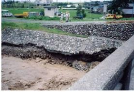
護岸基礎部の洗掘被災状況
