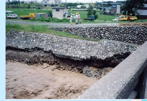
護岸基礎部の洗掘被災状況 (新潟県糸魚川市 鉅川) 平成7年7月洪水「梅雨前線」
