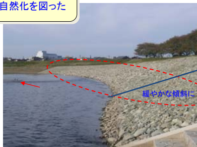
【 緩傾斜覆土型護岸 】
