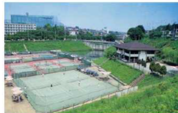
雨水貯留浸透施設の例(防災調整池)
