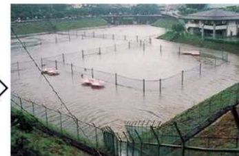
雨水貯留浸透施設の例(防災調整池)
