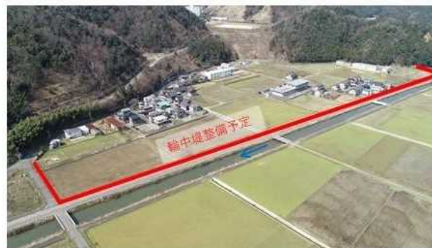
輪中堤整備(北川水系江古川)
