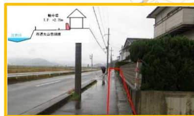
江古川地区の輪中堤整備(福井県)
