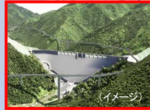
足羽川ダム建設（国）
