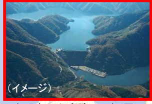
九頭竜川上流ダム再生（国）
